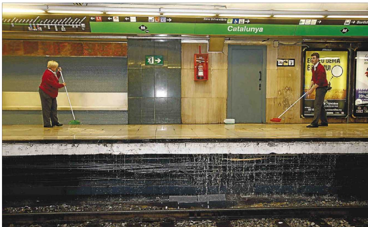
► Dos trabajadores del metro sacan agua de un andén inundado en la estación de Catalunya de la L-3, tras el aguacero caído el 15 de marzo.
