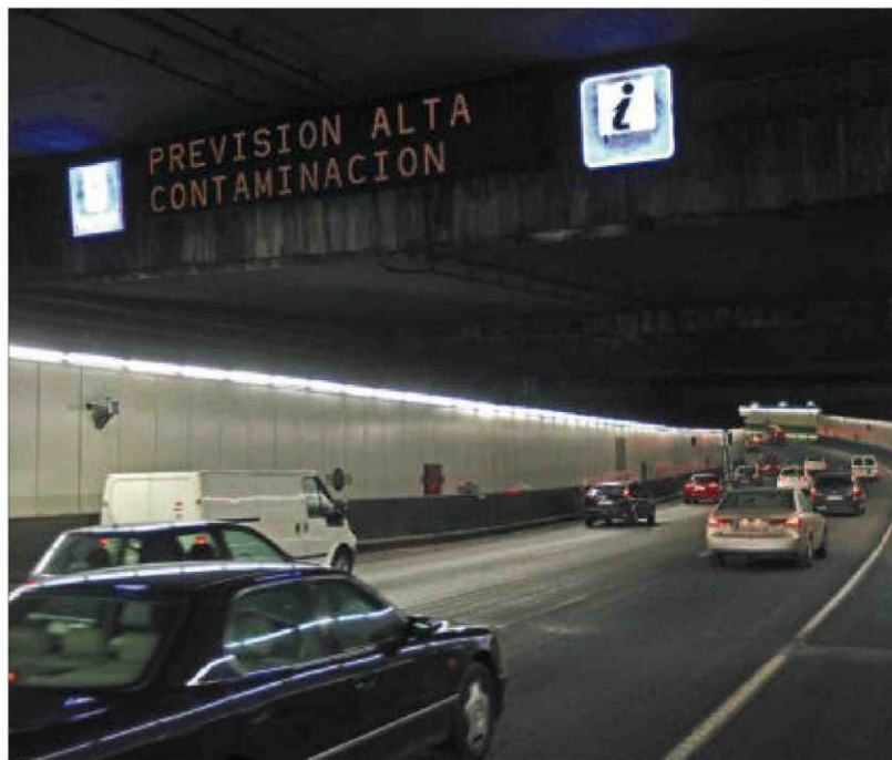
Carteles en los túneles de la M-30, vía de circunvalación de Madrid, alertando de la alta contaminación. / S. SÁNCHEZ
