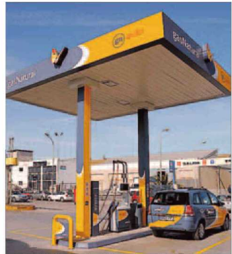
Estación de la Cooperativa del Taxi en Quart de Poblet, Valencia.
